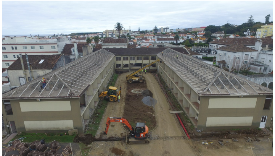
Obra de reabilitação do Hotel Canadiano
