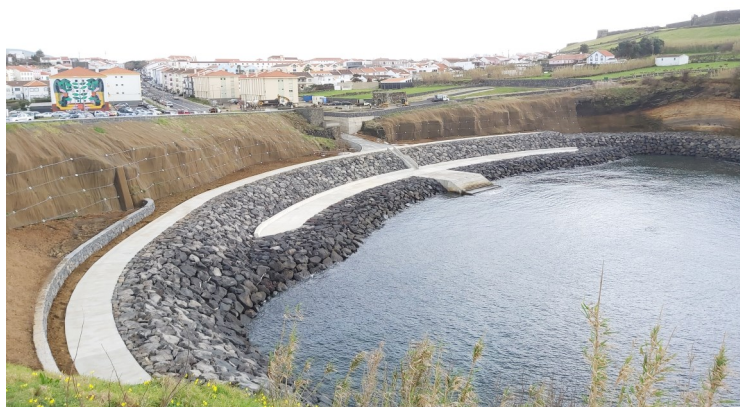
Empreitada de Proteção, Consolidação e Valorização da Baía do Fanal
